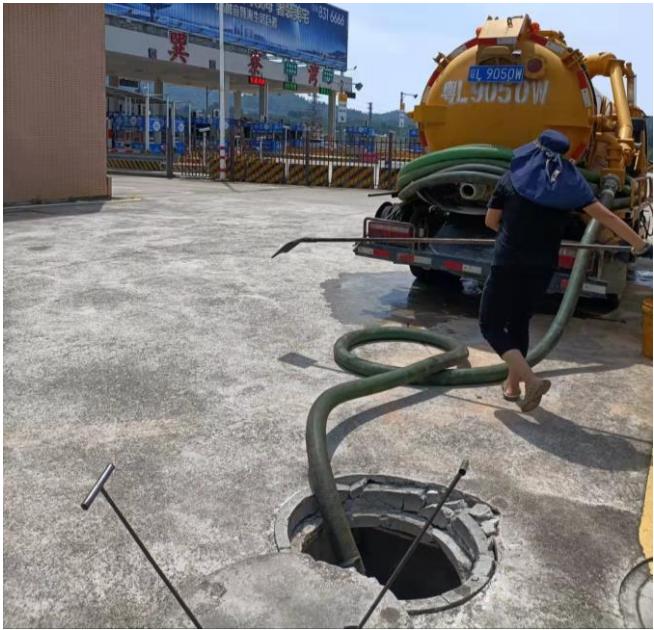
图 5.2-1 污水抽运照片
