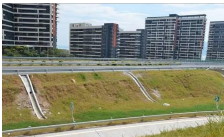
图 8.2-3 浆砌石排水沟
