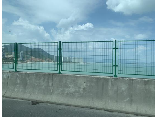
图 5.2-3 桥梁防护栏及防落网
