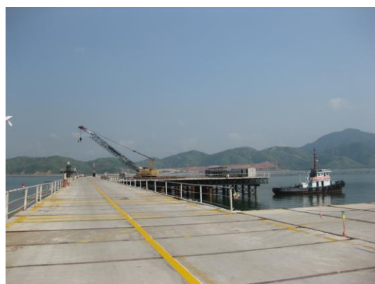
水上施工平台
